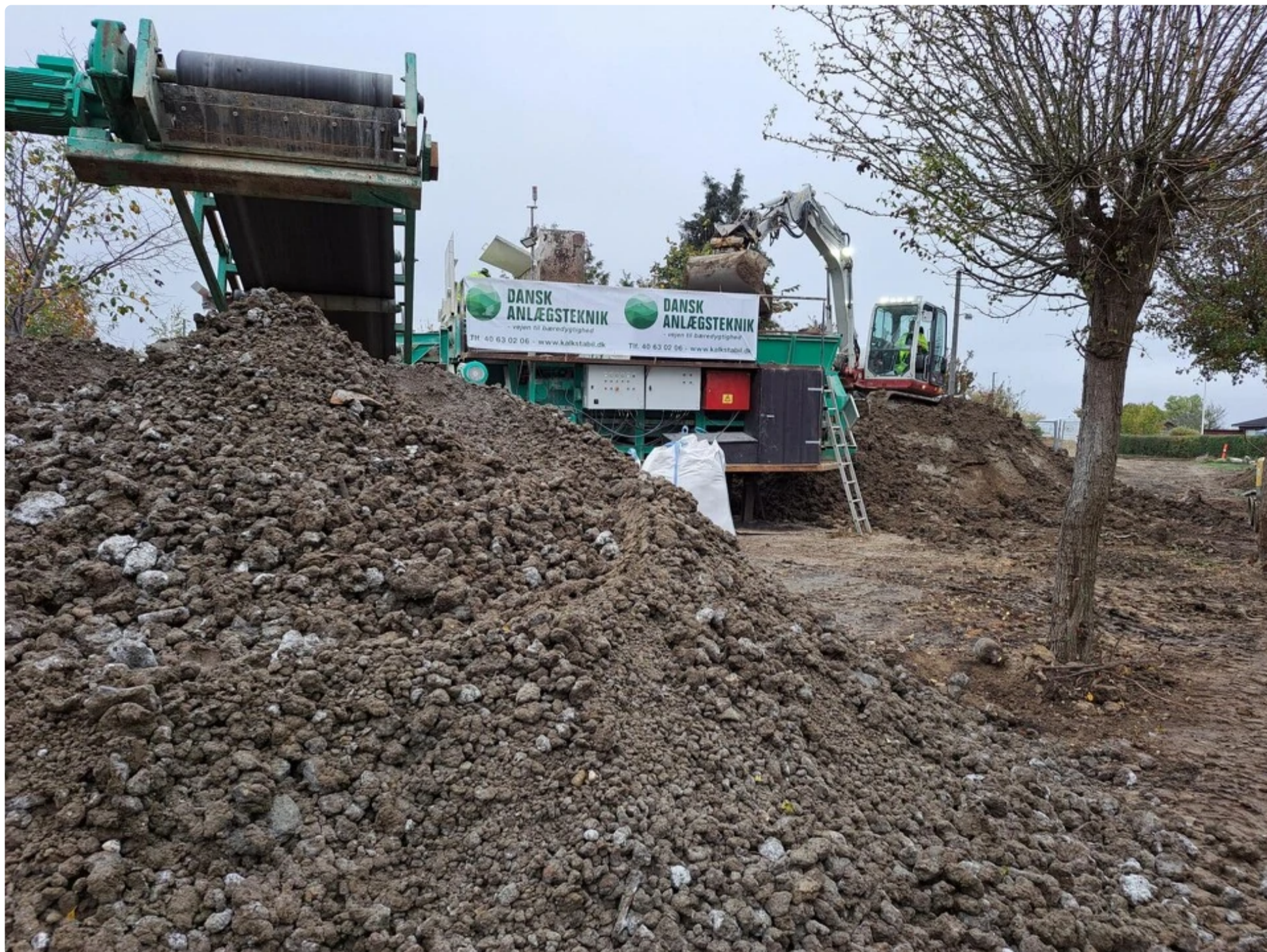
Kalkstabilisering er behandling af lerjord med brændt kalk. Foto: Dansk Anlægsteknik ApS.
