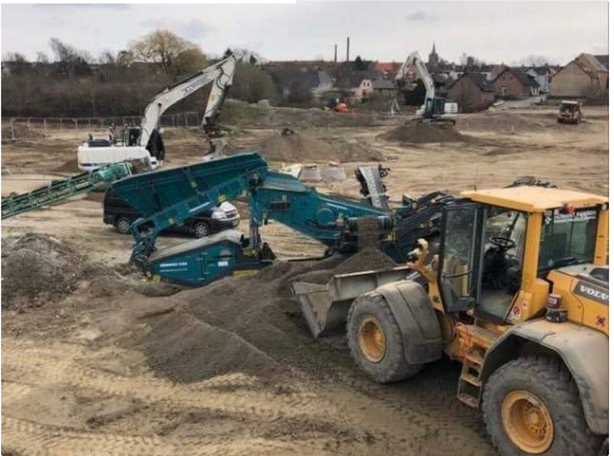
Blandeanlægget omdanner våd lerjord til et produkt, der ligner sand og grus. Foto: Dansk Anlægsteknik ApS.
